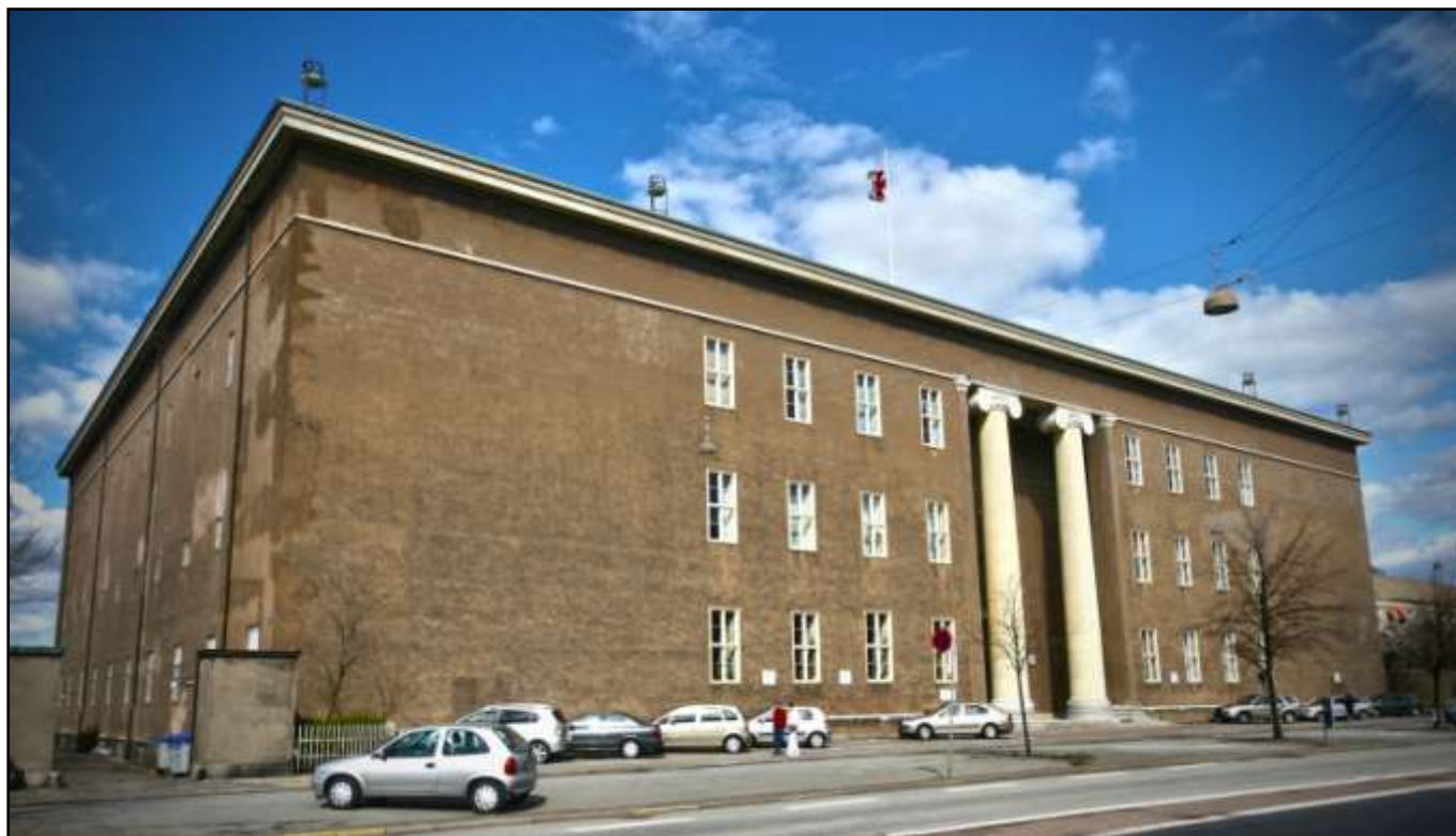
Stamhuset på Blegdamsvej er på 13.515 m 2 , hæver sig 20 meter over gadeniveau, indeholder ca. 335 rum og har en kælder, der går 7 meter i jorden. De to søjler på facaden er 16 meter høje og vejer hver 72 tons.
