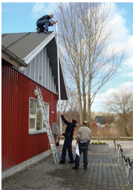
Foto 2. Reparation af stander
