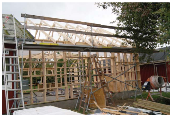
Foto 4. Skallen til tilbygningen ved at være på plads
